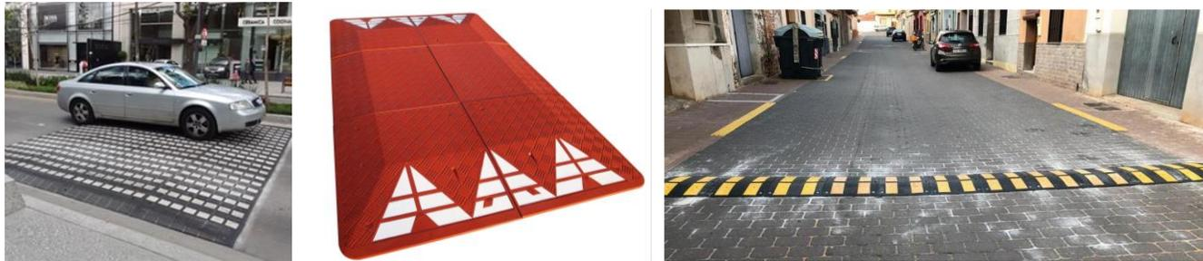
Imagen 6-8 Meseta reductora de velocidad y cambio de pavimento
