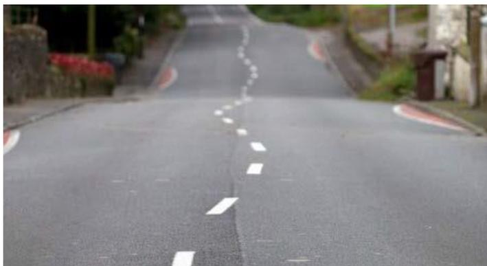
Imagen 6-22 Ejemplo de desviación del eje de trayectoria
