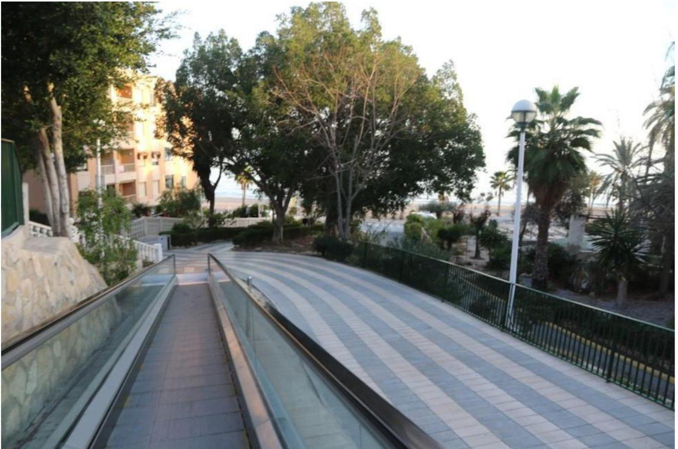
Imagen 6-103 Ejemplo de rampa mecánica instalada para mejorar la accesibilidad en Villajoyosa
